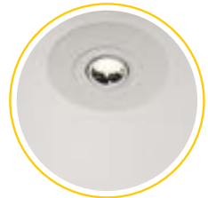
6. Новый встраиваемый потолочный светильник размещен в переходном кольце.
